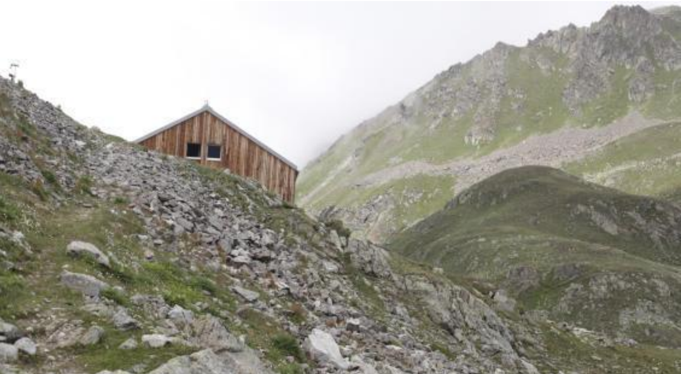
Nebel über dem Neubau: Die Keschhütte wirtschaftet energieautark.
